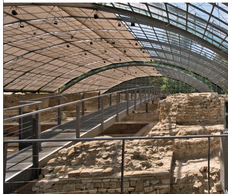
Des passerelles enjambent les vestiges des bains romains qui sont les mieux conservés au nord des Alpes
