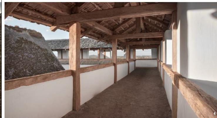
❖ Le mur de pierres blanches a été érigé en briques d'argile selon le modèle méditerranéen. La chaux était utilisée pour protéger le mur contre l'humidité
